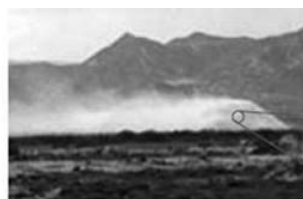
Erosión eólica (por viento) de un jale minero en un medio ambiente semiárido típico.
